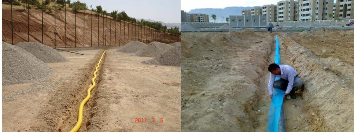
وتغطا الماسورة بطبقة (حصى) بسمك ٢٥سم وعادة توضع طبقة نسيجية من Geotixyle تعمل على إزالة الشوائب من المياه الزائدة فوق طبقة الحصى لتعمل على منع الشوائب والمواد الدقيقة من التراكم داخل الانابيب الصرف فتسدها بالتراكم نهاية خطوط الصرف تتصل بزاوية اتصال ٤٥° توضع هذه الأنابيب في قنوات تم تجهيزها محاطة بطبقة من الحصى تعلوها طبقة الفلتر تصب في اقرب مطبق ويتميز هذا النظام بسهولة وقلة تكاليفه وهو مستخدم في معظم الملاعب .
